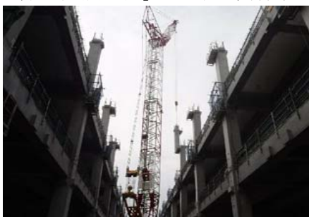
3階柱 立て込み
