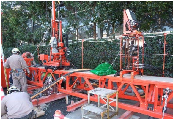
宅地内改良体施工機械(舞浜)
